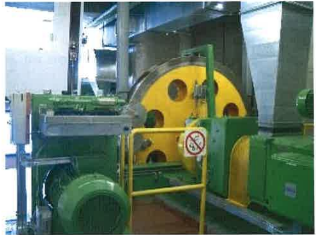
FOTO N. 7BIS : MOTORE E SISTEMA FRENANTE FUNIVIA
