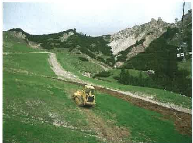
FOTO N. 29: MEZZO CINGOLATO PER MOVIMENTO TERRA
