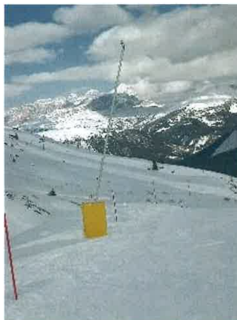
FOTO N. 21: LANCE IN POSTAZIONE FISSA PER INNEVAMENTO ARTIFICIALE
