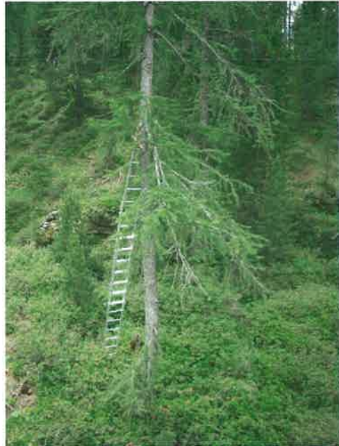
FOTO N. 30BIS: TAGLIO RAMI LUNGO IL PERCORSO DELLA SEGGIOVIA
