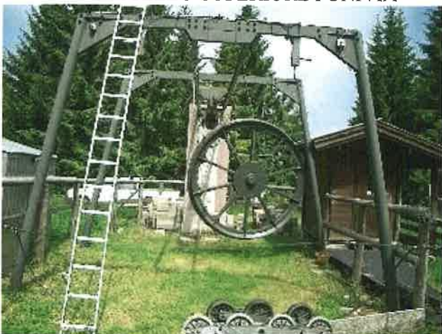
FOTO N. 16 TER: FASI DI MANUTENZIONE E VERIFICA SEGGIOVIA
