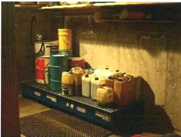
FOTO N. 37: BACINO DI CONTENIMENTO PER OLII E COMBUSTIBILI
