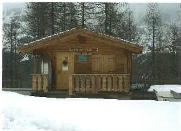
FOTO N. 42: LOCALE RISERVATO AGLI AGENTI P.S.
