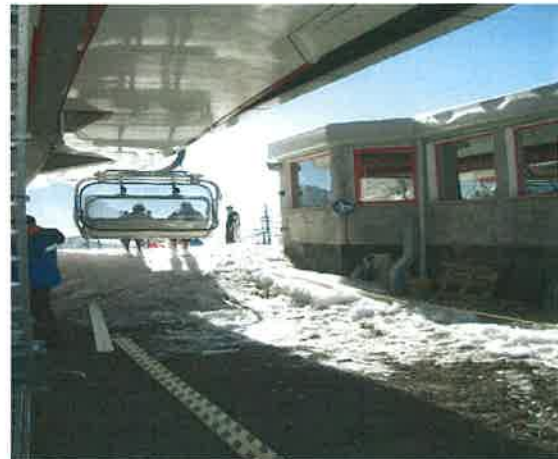
FOTO N. 6: STAZIONE ARRIVO SEGGIOVIA AGGANCIAMENTO AUTOMATICO
