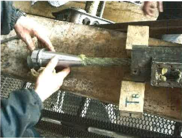
FOTO N. 14: CONFEZIONAMENTO DI TESTE FUSE (FUNIVIA)
