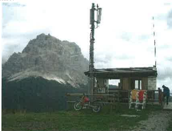
FOTO N. 45: ANTENNA DI TELEFONIA MOBILE PRESSO UNA STAZIONE DI ARRIVO
