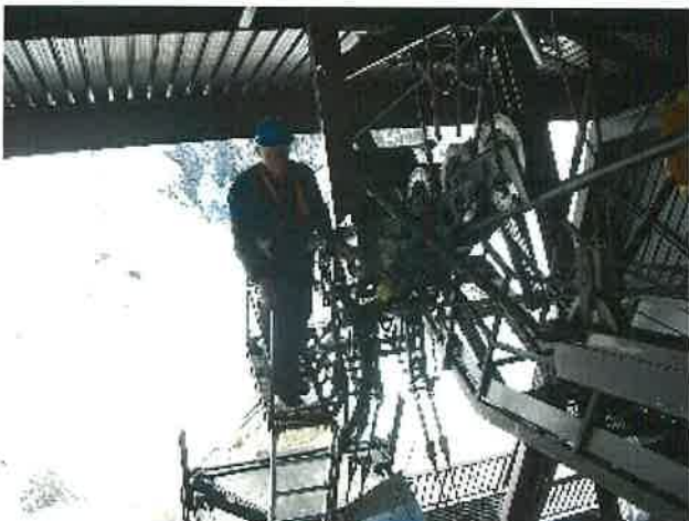
FOTO N. 16: FASI DI MANUTENZIONE E VERIFICA SUL CESTELLO SUPERIORE FUNIVIA
