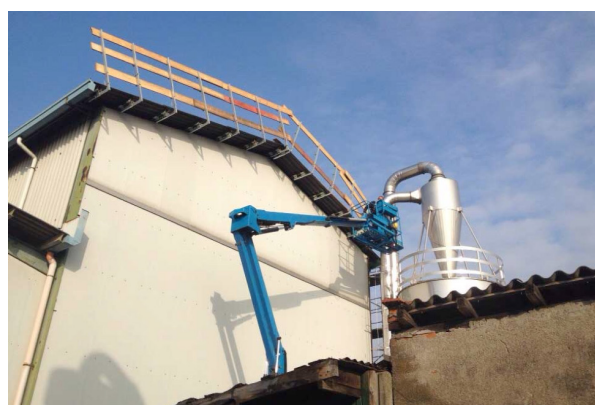
6. Montaggio parapetti con PLE
